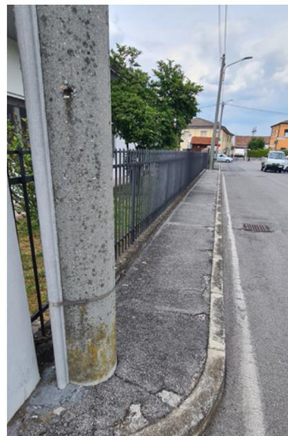
Descrizione prestazionale possibile intervento: Rifacimento del marciapiede o percorso pedonale esistente previa demolizione della pavimentazione compreso il sottofondo. Il nuovo piano di calpestio dovrà risultare compatto, omogeneo con pendenza trasversale non superiore all'1%.
